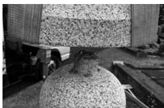
ブチルゴムを主成分とする接着剤『ソフトファスナー・C』による施工の様子(大代社長提供)
